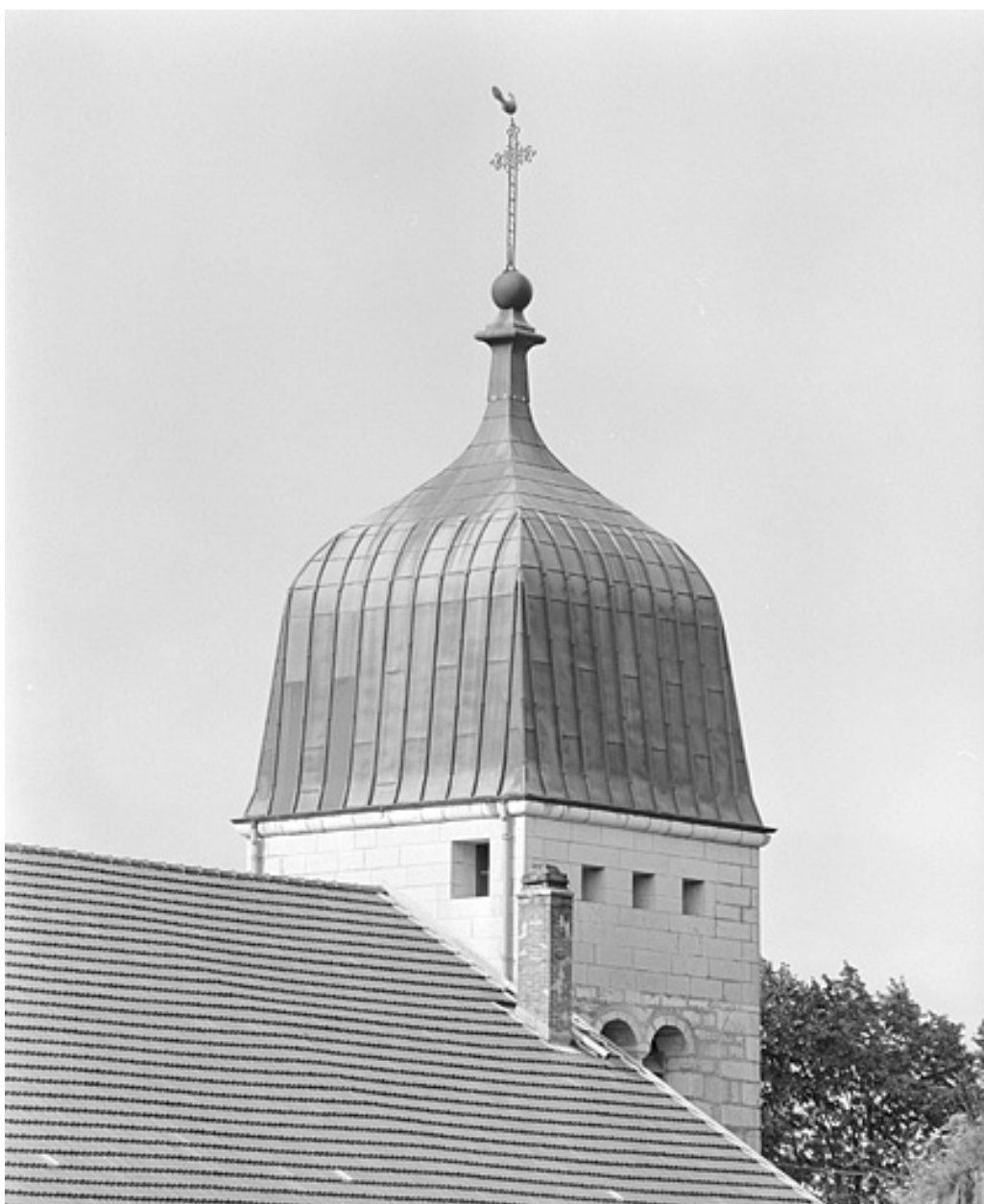
Partie supérieure de la tour-clocher.
