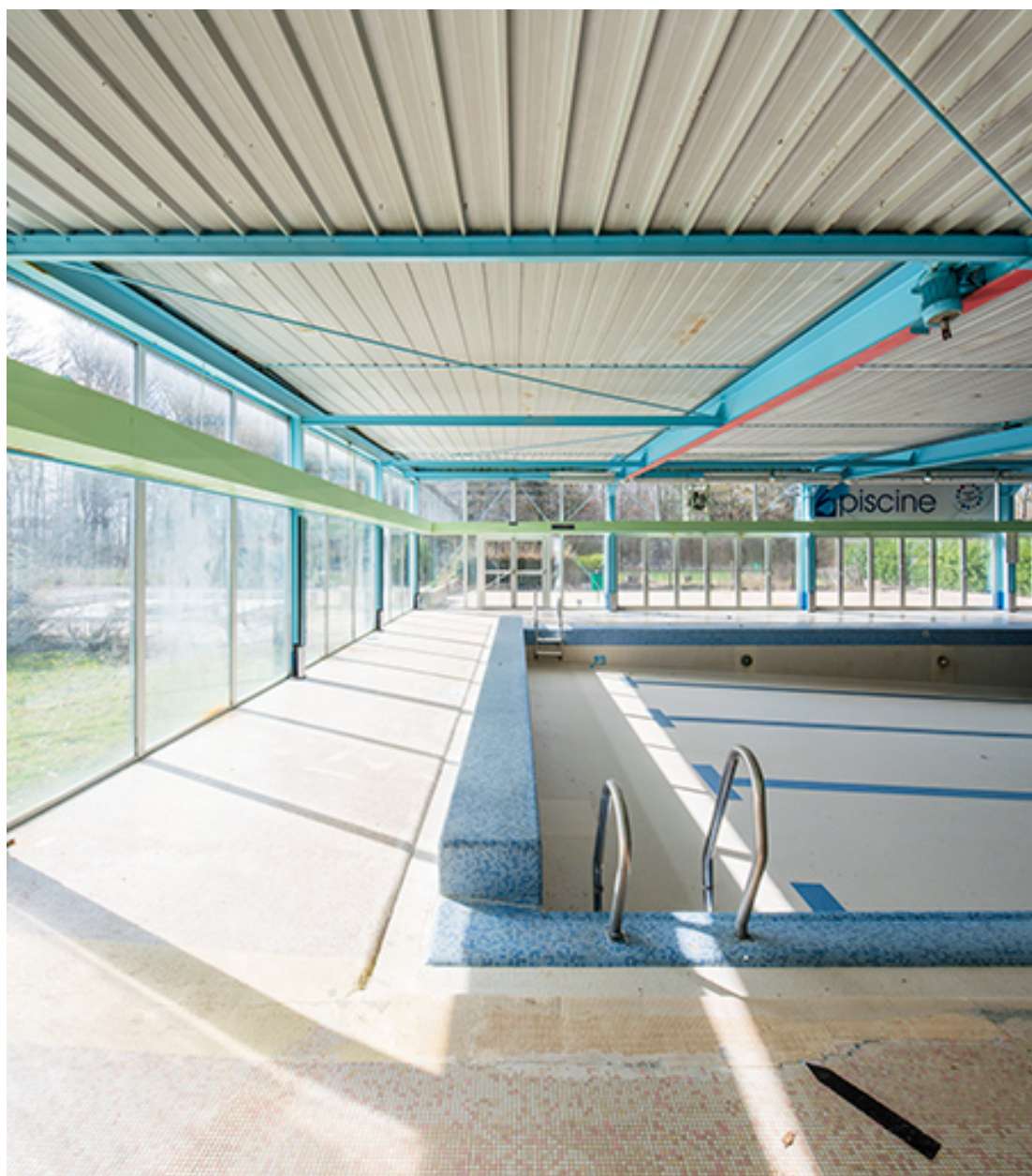
L'entrée du bassin depuis les vestiaires des filles.
