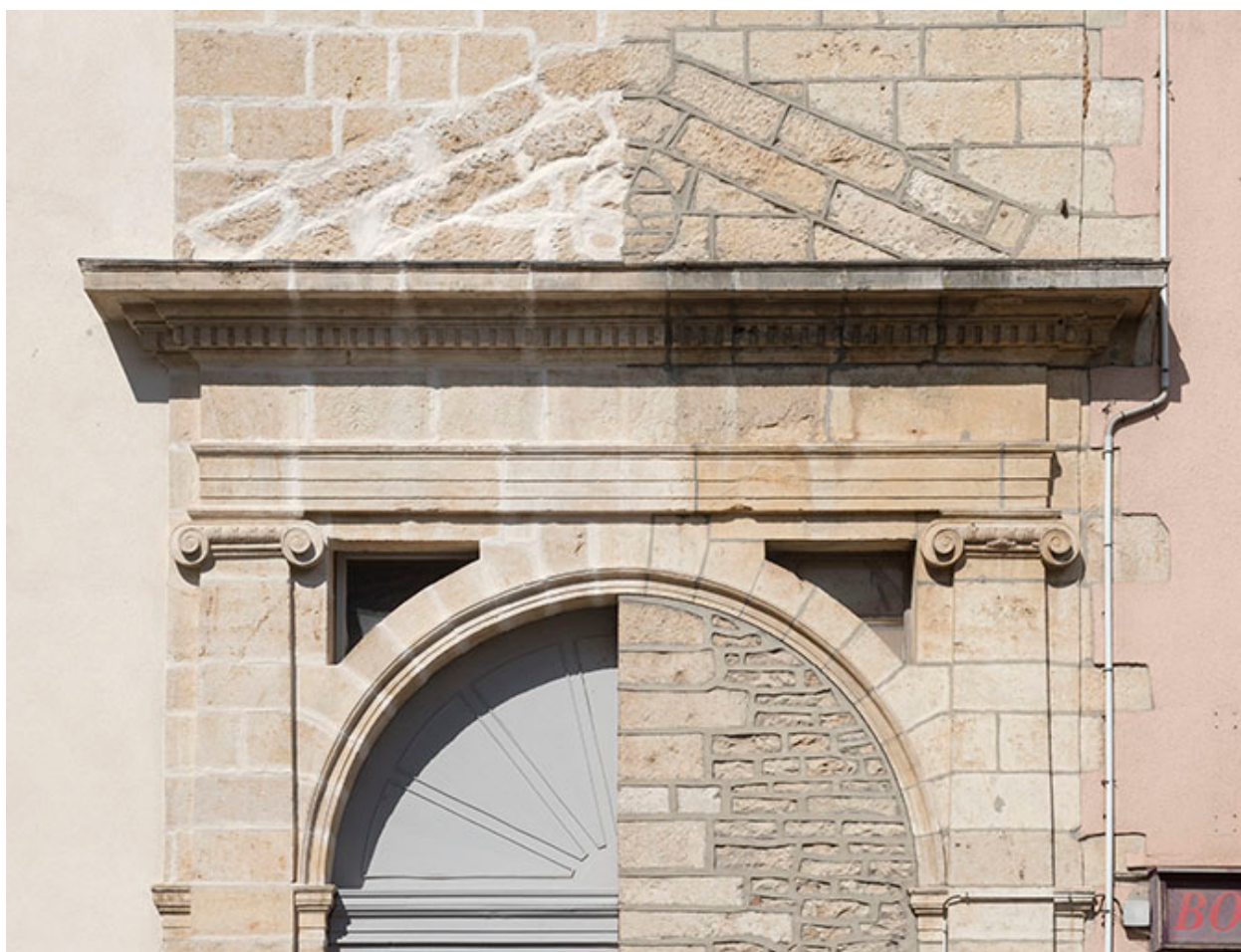
Ancien portail d'entrée, rue Armand-Paulmard, détail.
