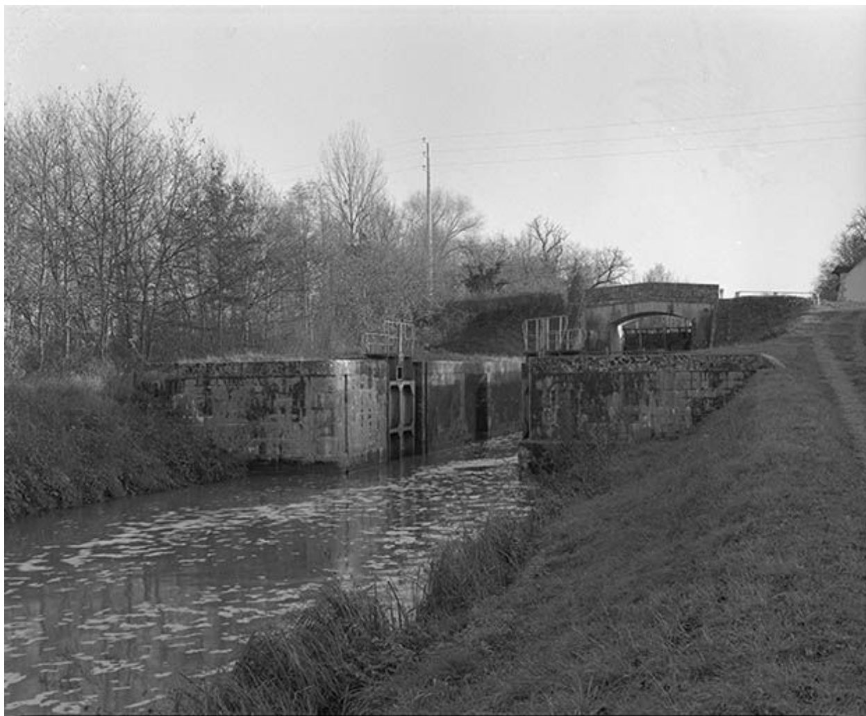
Le pont et l'écluse. Vue d'ensemble.
