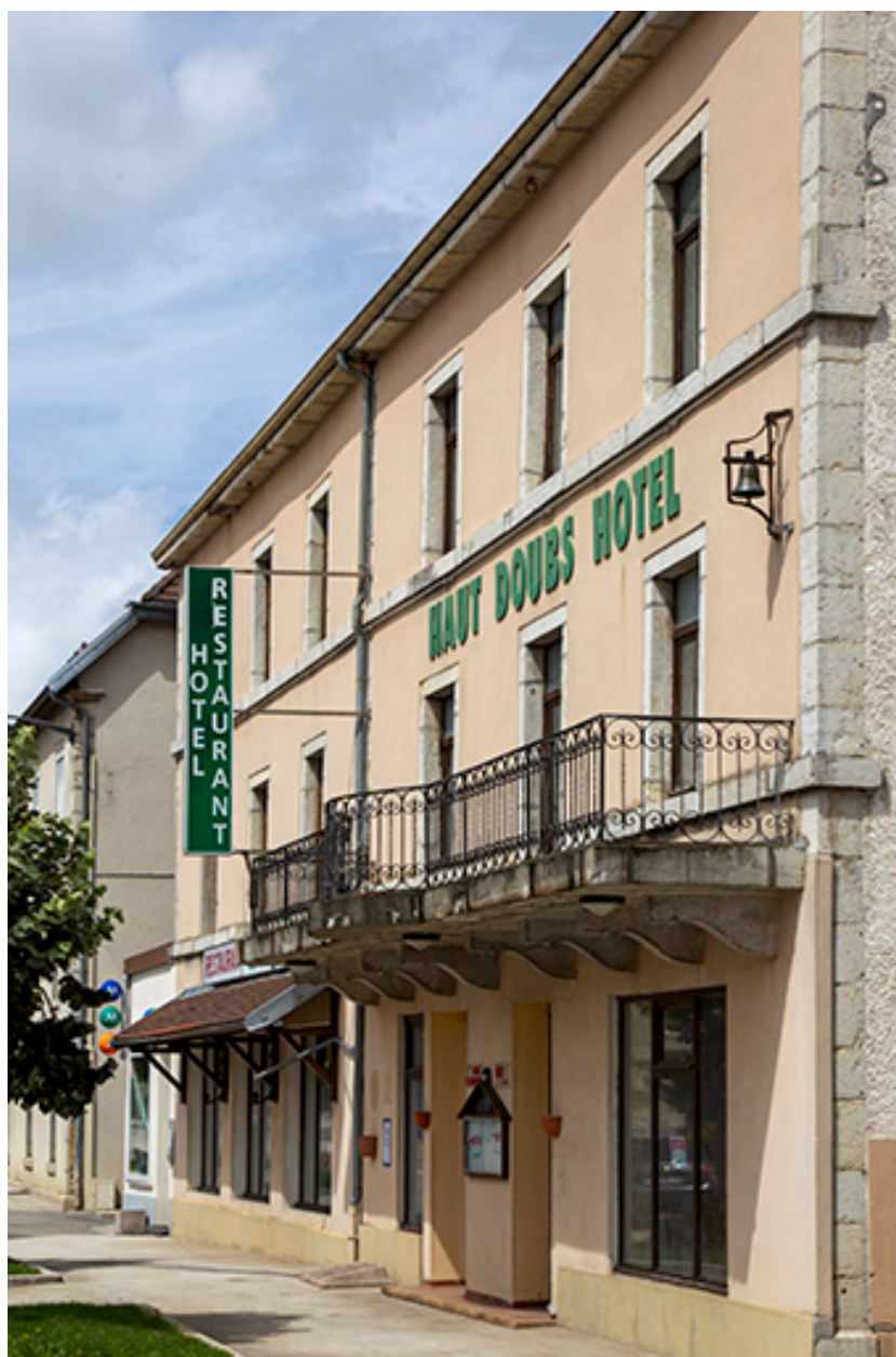
Façade antérieure, vue en enfilade.
