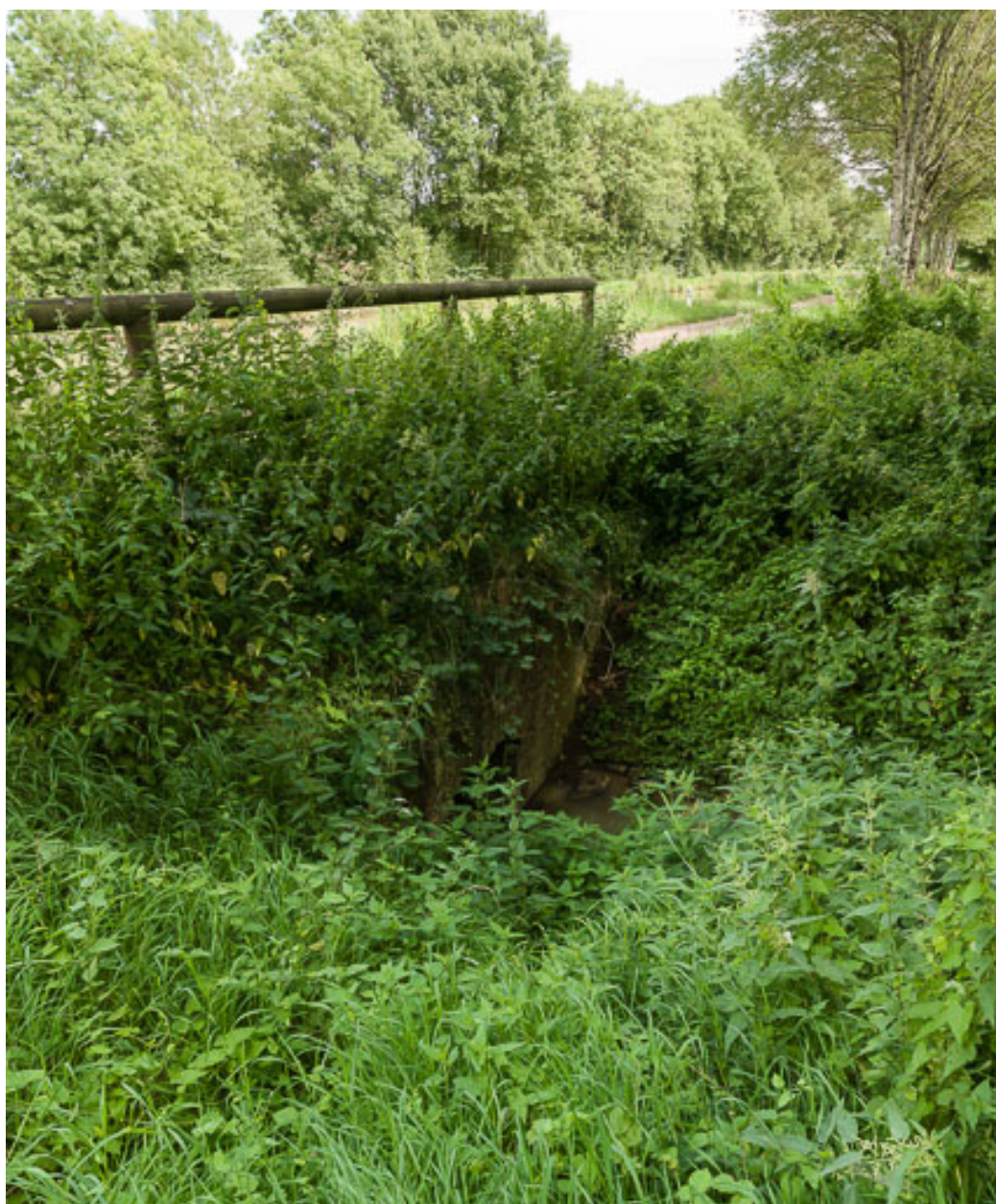
Vue de l'aqueduc.
