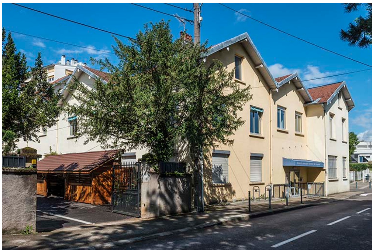
Pignons des ateliers sur la rue Violet.
