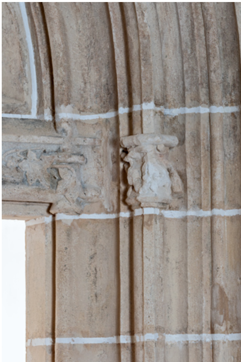
Détail : piédroit, partie supérieure.
