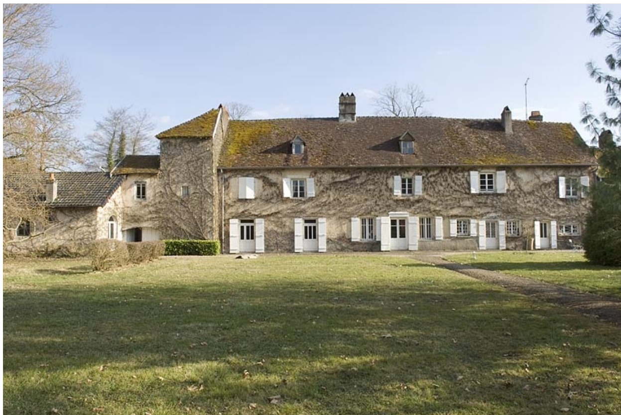
Façade postérieure du logis ouest.
