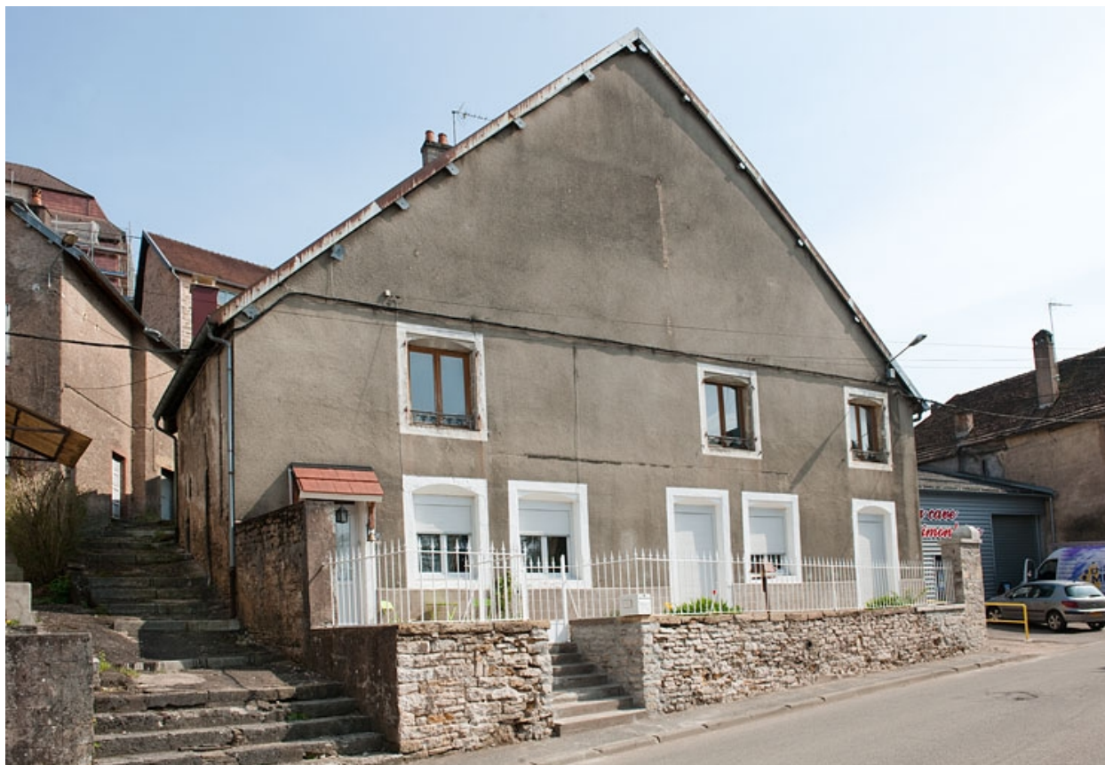
Maison au 25 Grande Rue (2010 AL 461).
