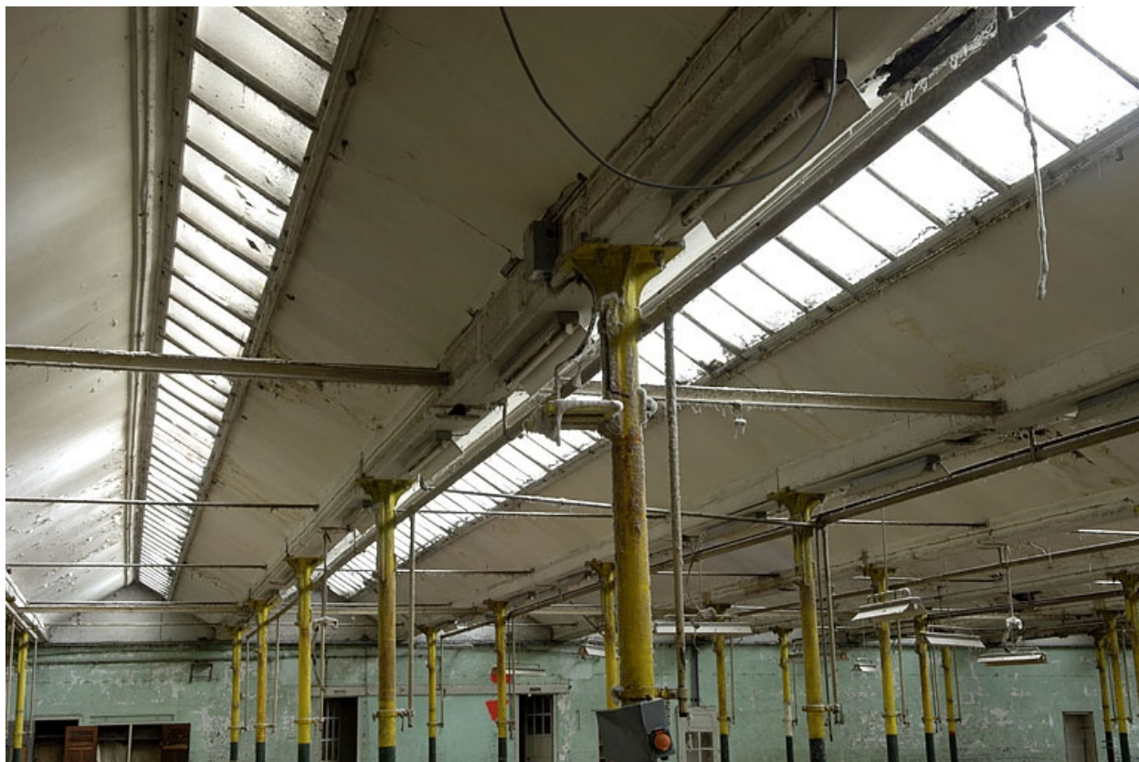
Salle de tissage. Détail des sheds.
