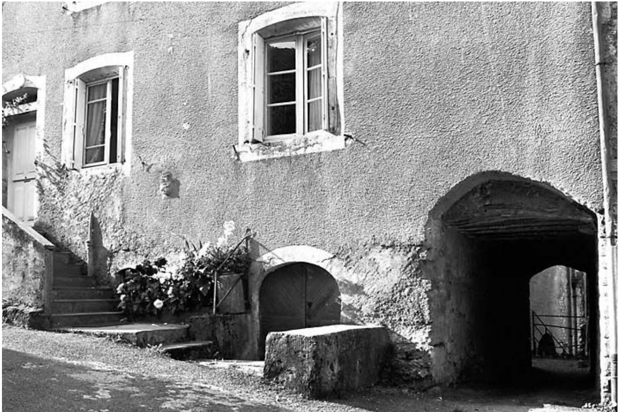
Vue du rez-de-chaussée.
