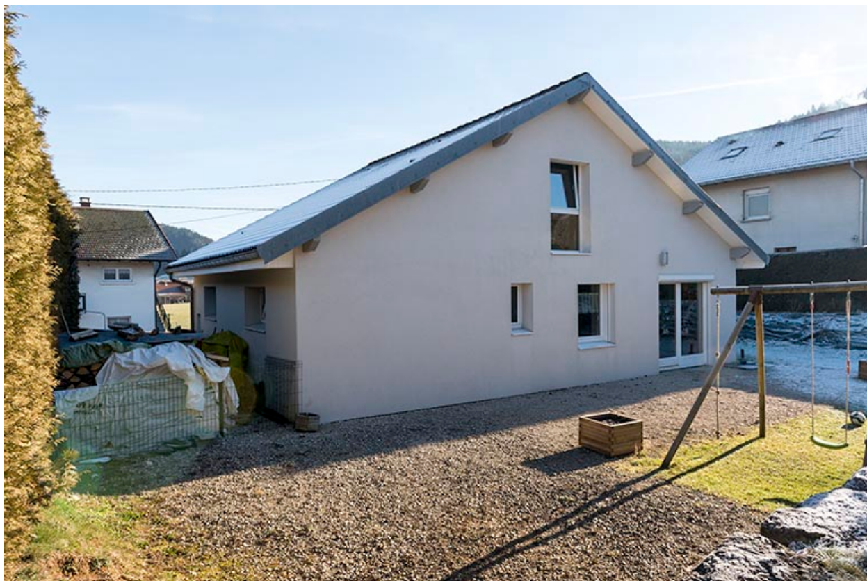
Façades postérieure et latérale droite.
