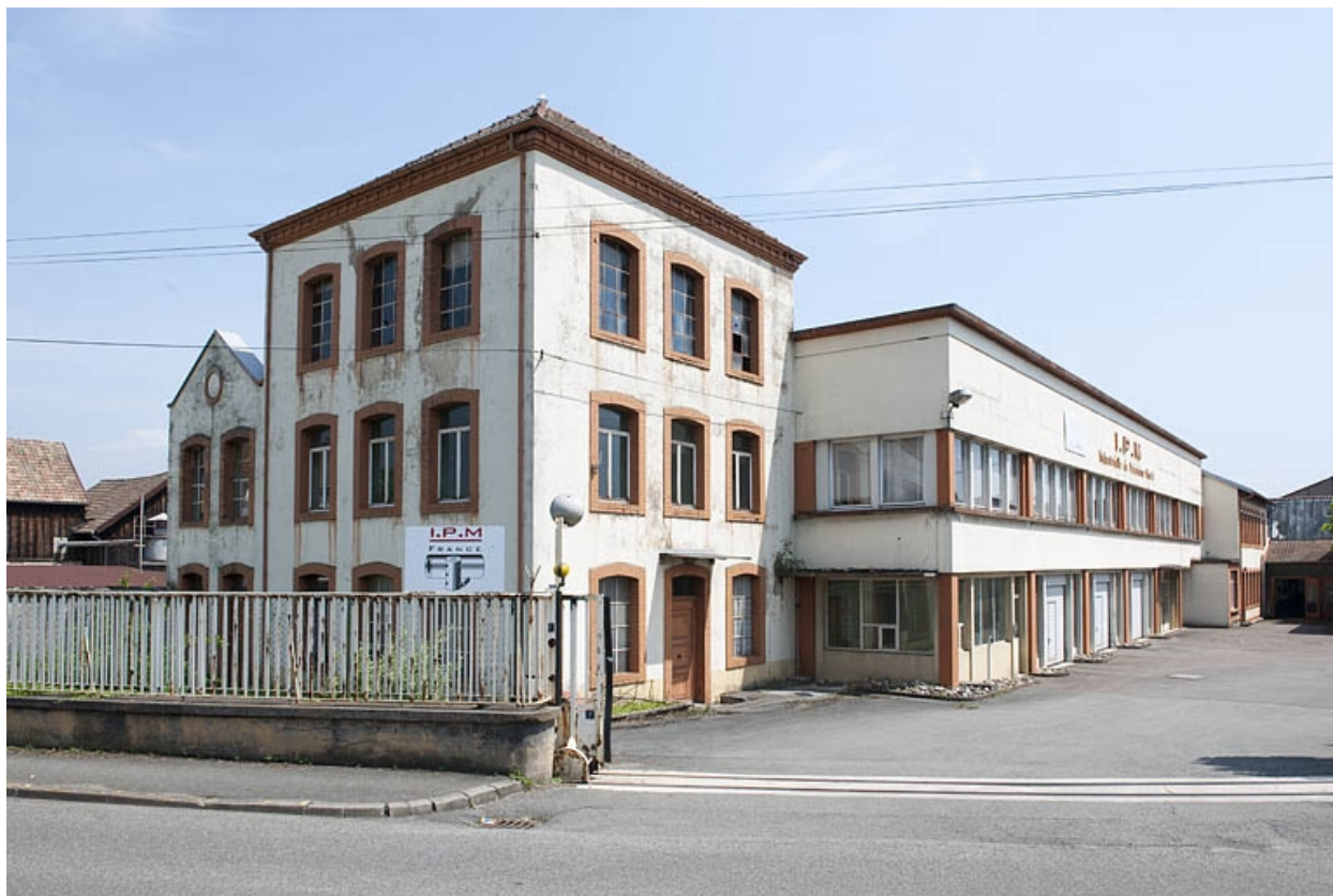
Usine Fritz Marti, à Vieux-Charmont.
