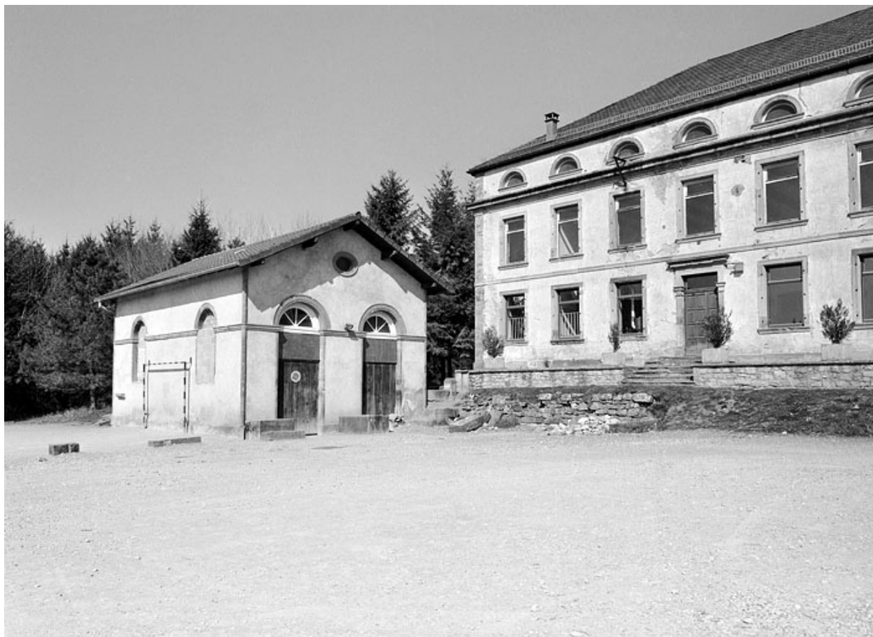
Salle des machines.
