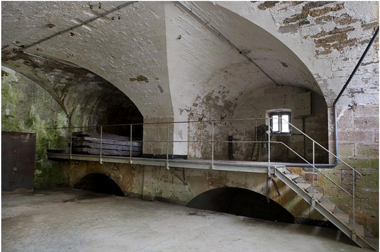
Intérieur de la casemate amont : coursiers voûtés.
