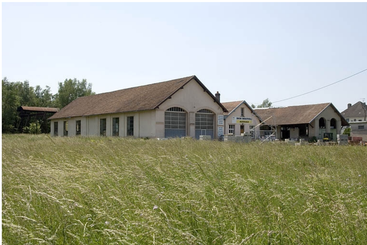
Mine de houille du puits Saint-Joseph, Ronchamp : vue d'ensemble.
