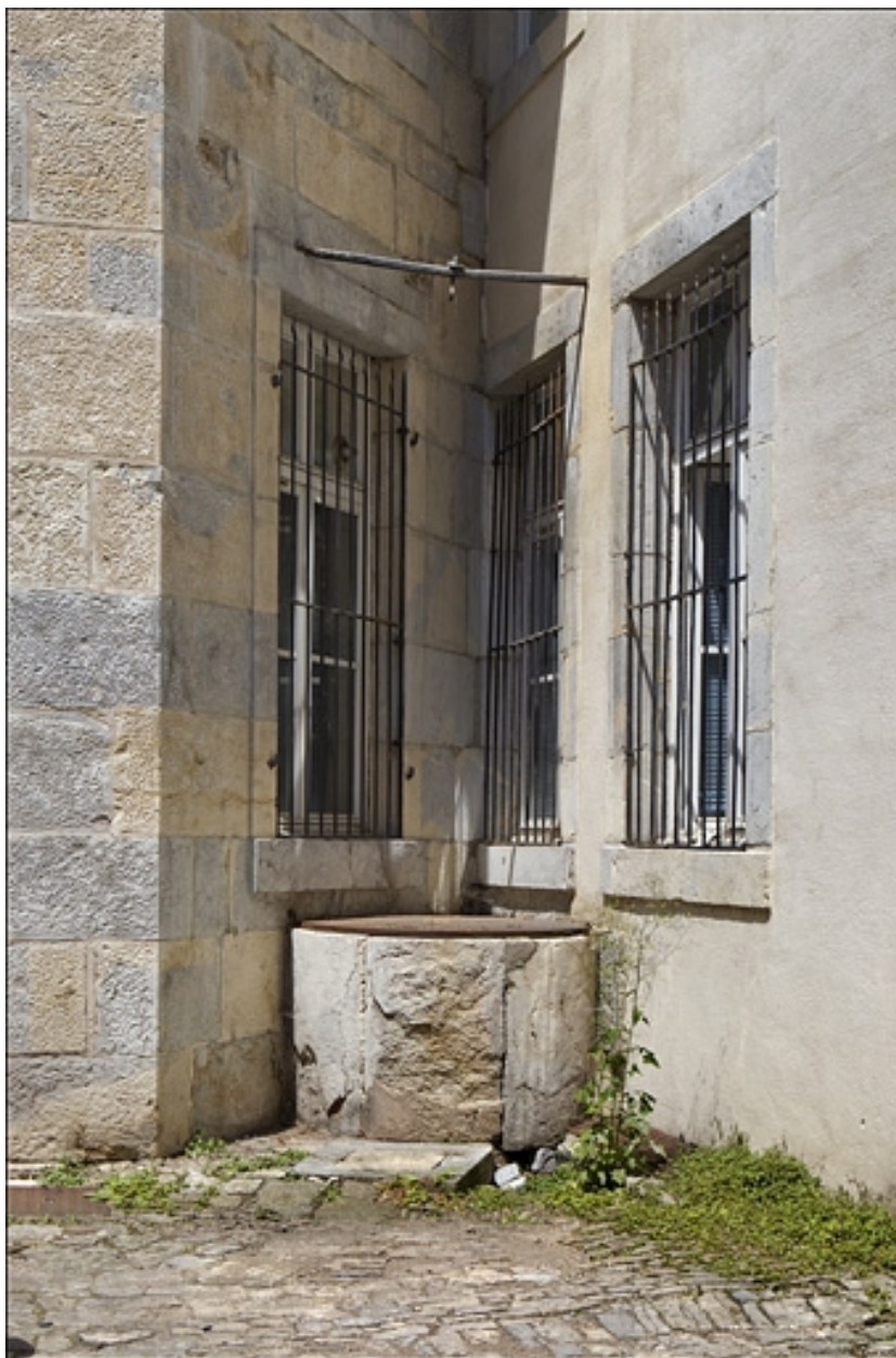
Deuxième cour : détail du puits.
