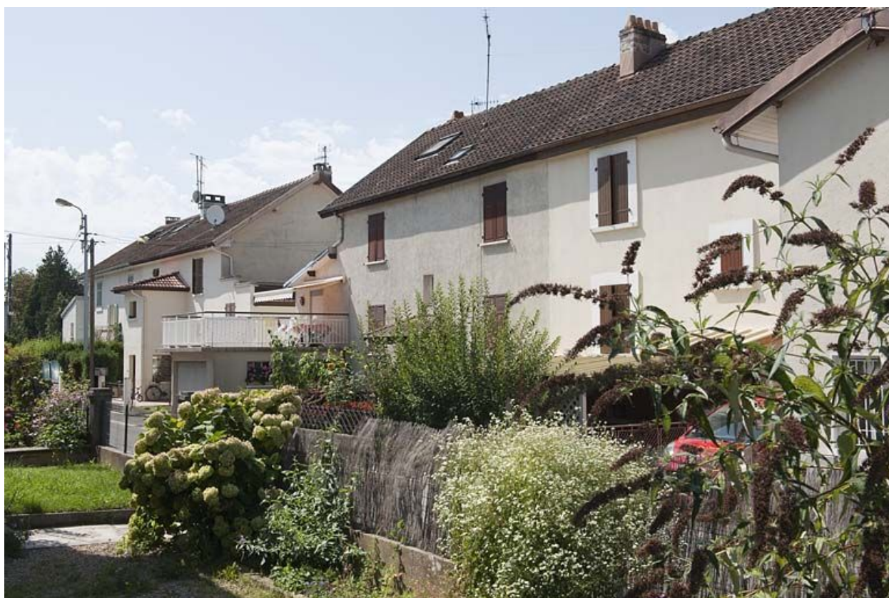
Façades postérieures vues de trois quarts.
