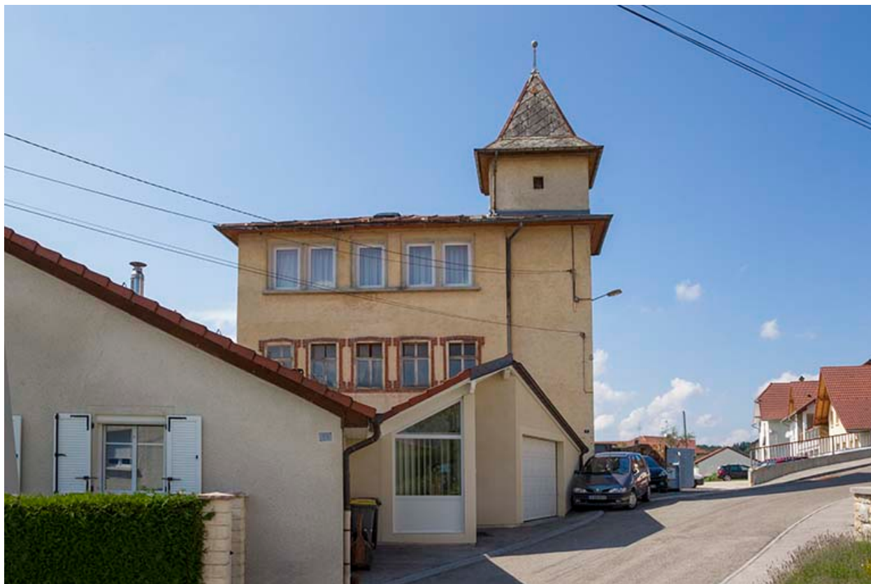
Usine : façade latérale droite.
