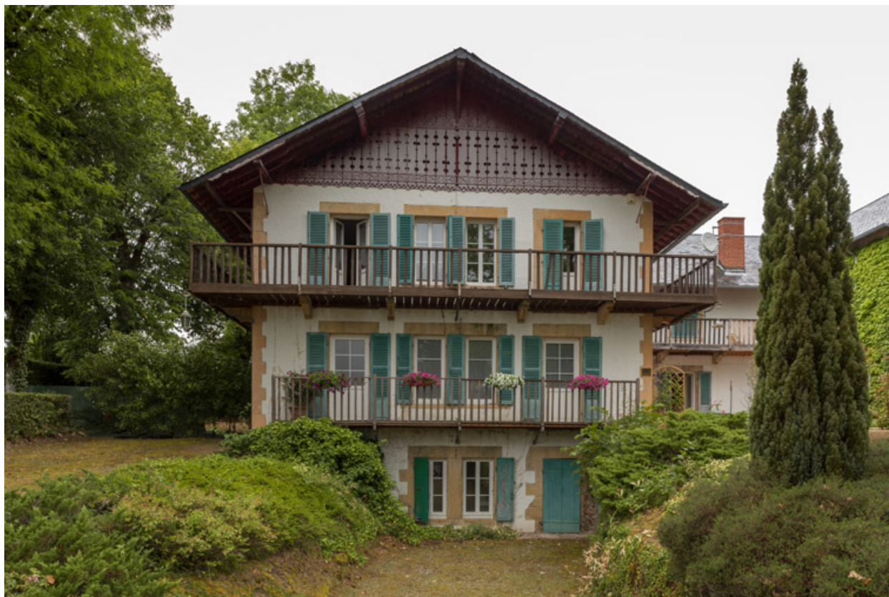
Façade du corps principal, vue de face.
