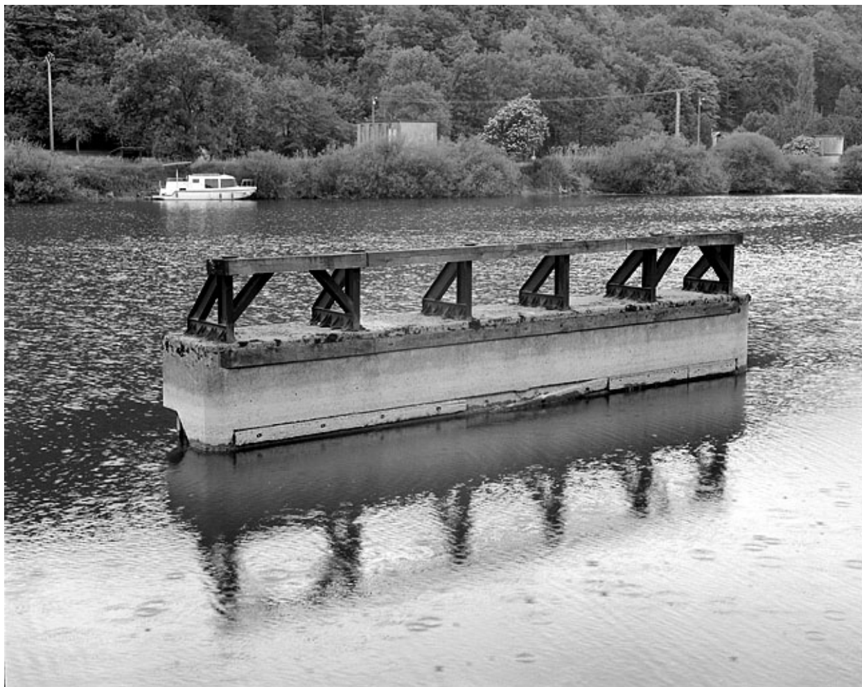
Un des éléments du mur guide.
