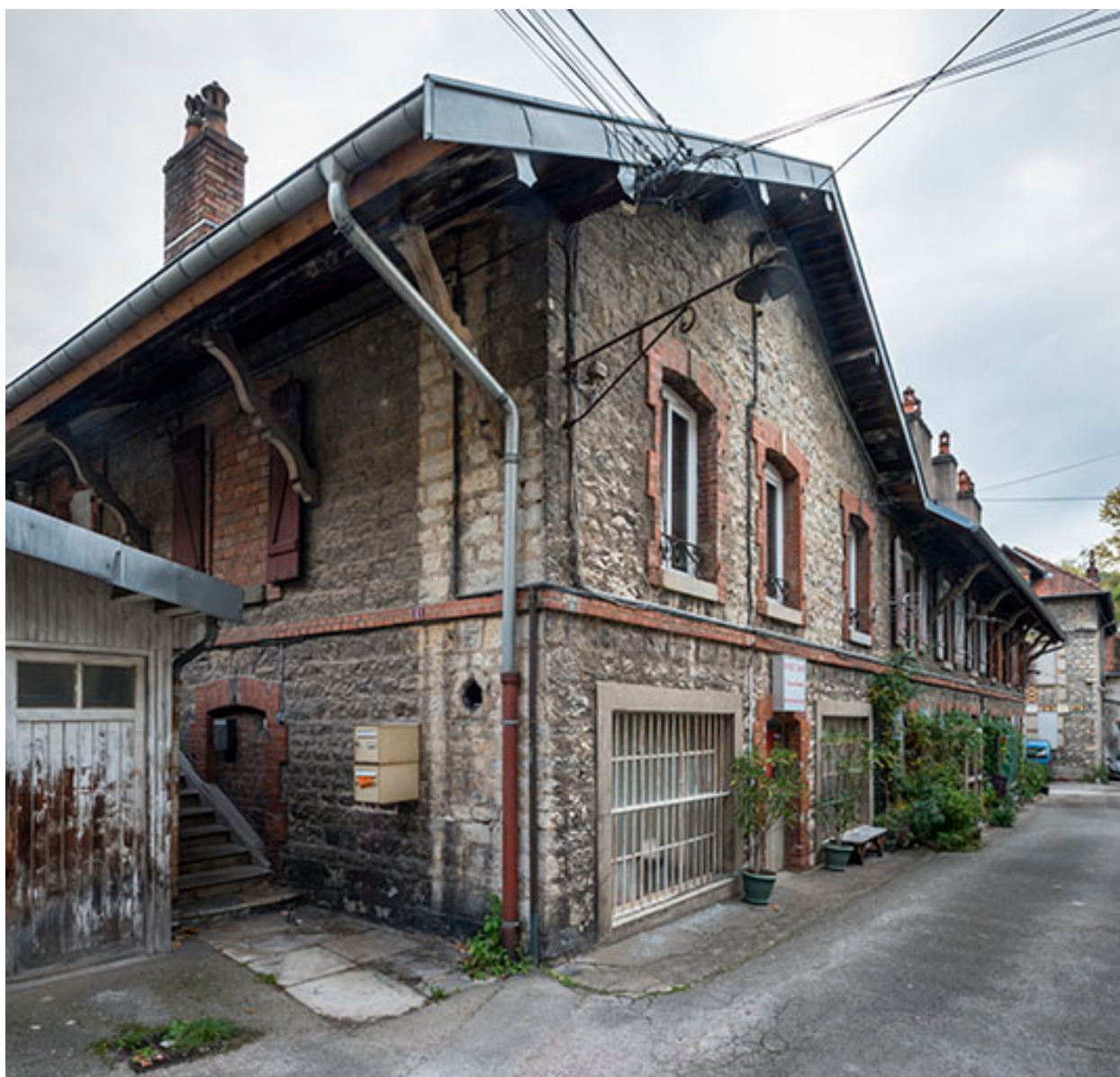
Pignon et façade sud de la distillerie.
