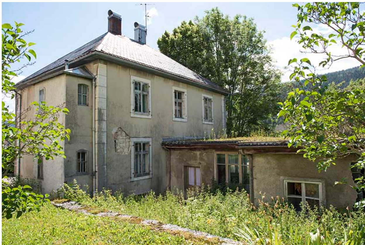
Façade postérieure et atelier de fabrication.
