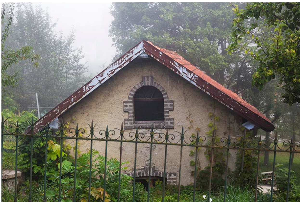
Bûcher : pignon sud.
