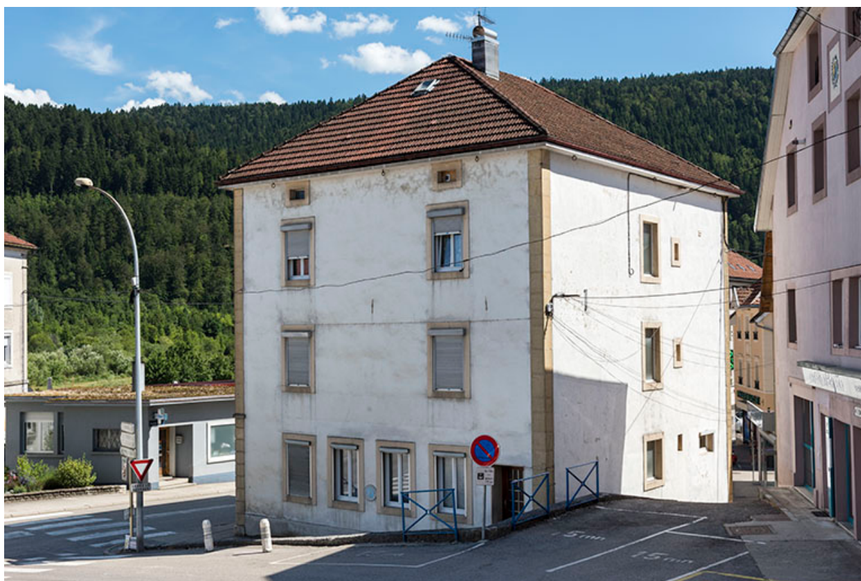
Façades postérieure et latérale droite.
