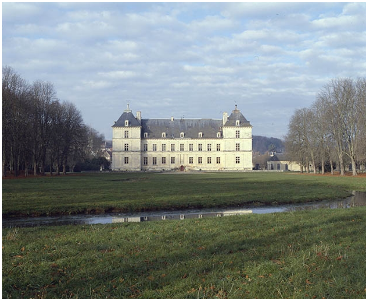
Vue d'ensemble de l'élévation sud.
