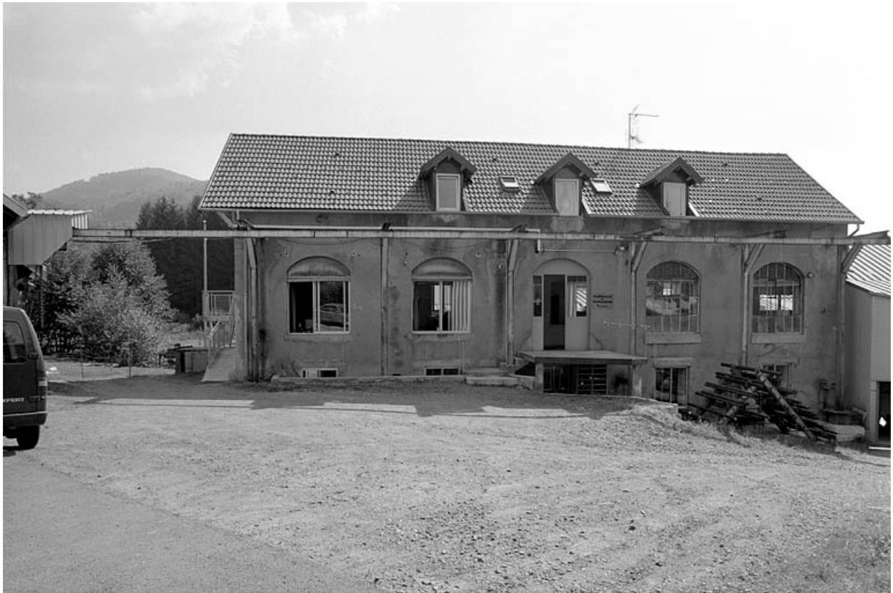
Façade ouest de l'atelier de fabrication primitif.
