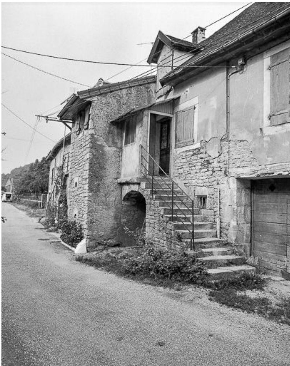
Façade antérieur : escalier à droite de l'avancée.
