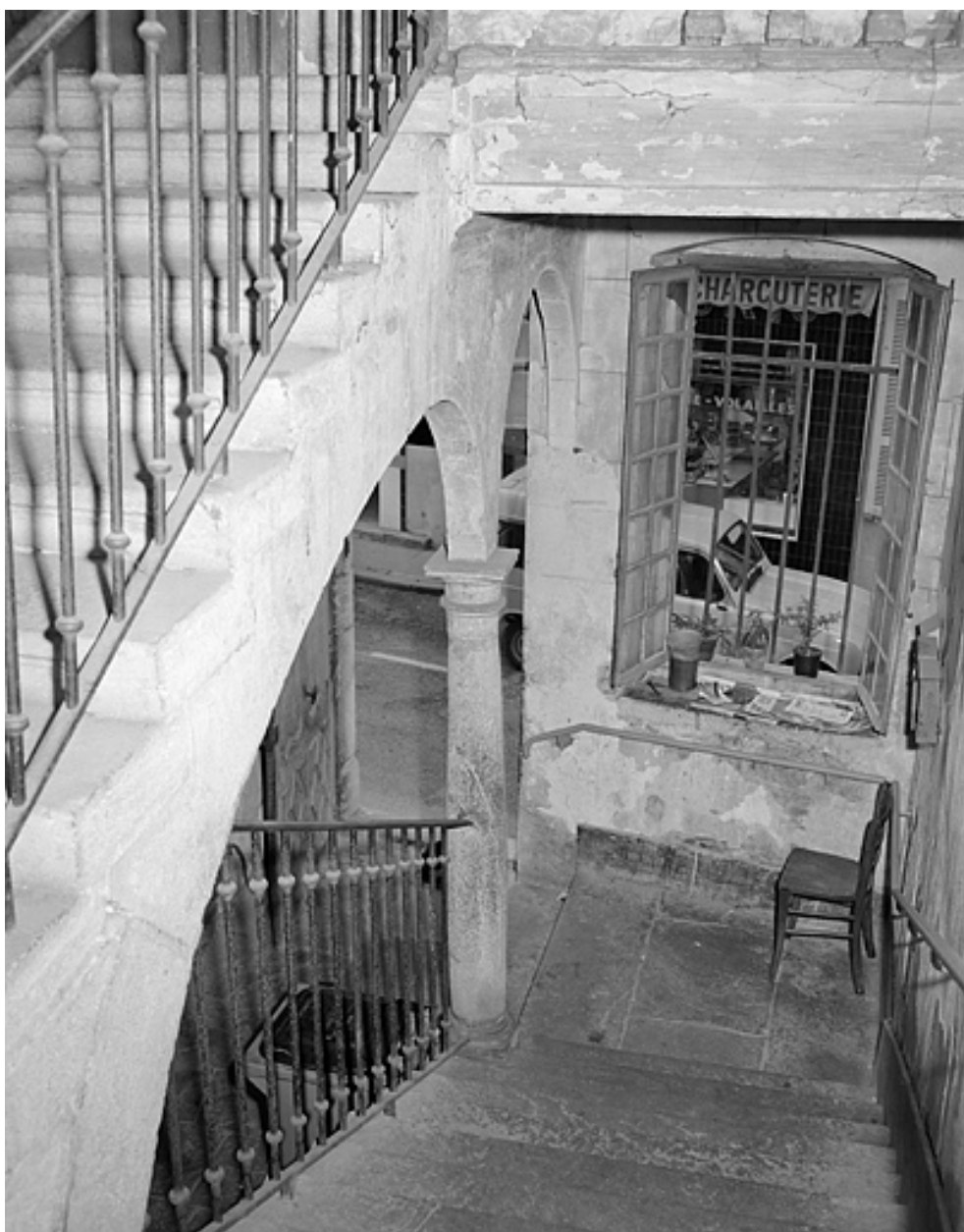
Escalier vu depuis le premier repos.
