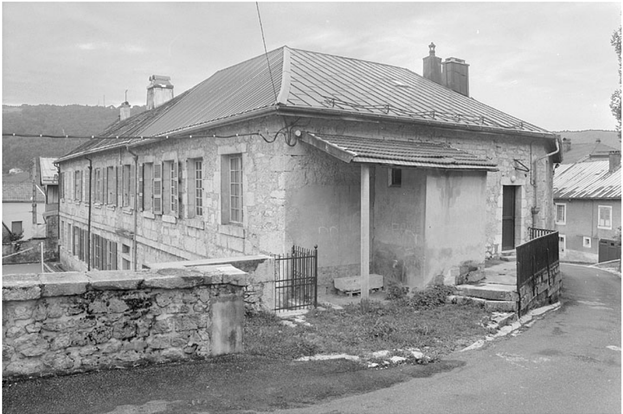
Façade postérieure et face ouest.
