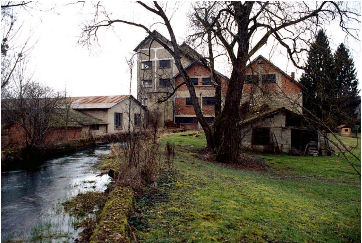
Façades postérieures depuis le canal d'amenée.
