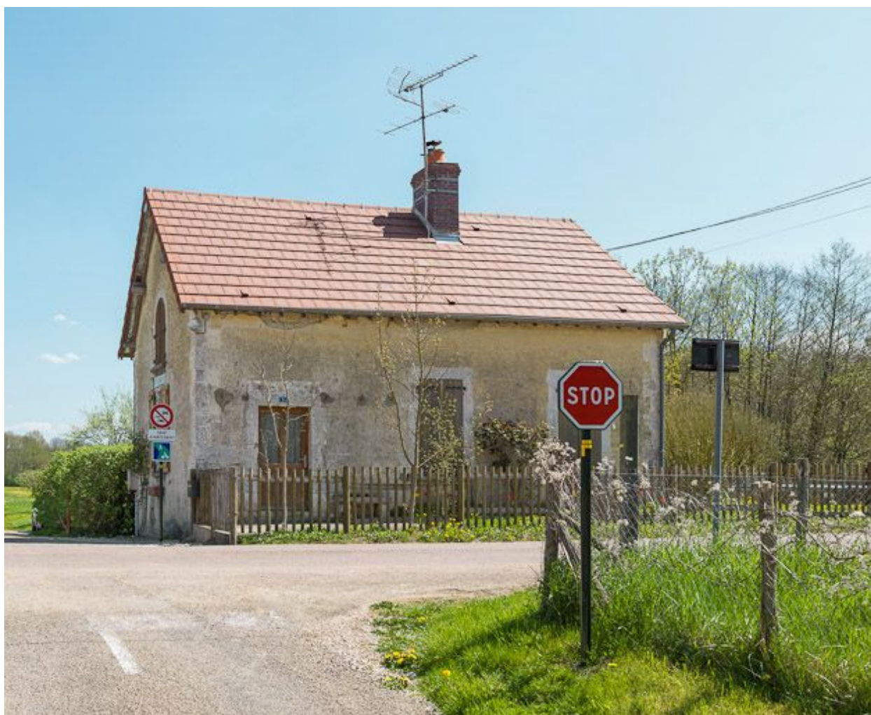
Maison éclusière, façade sur route.
