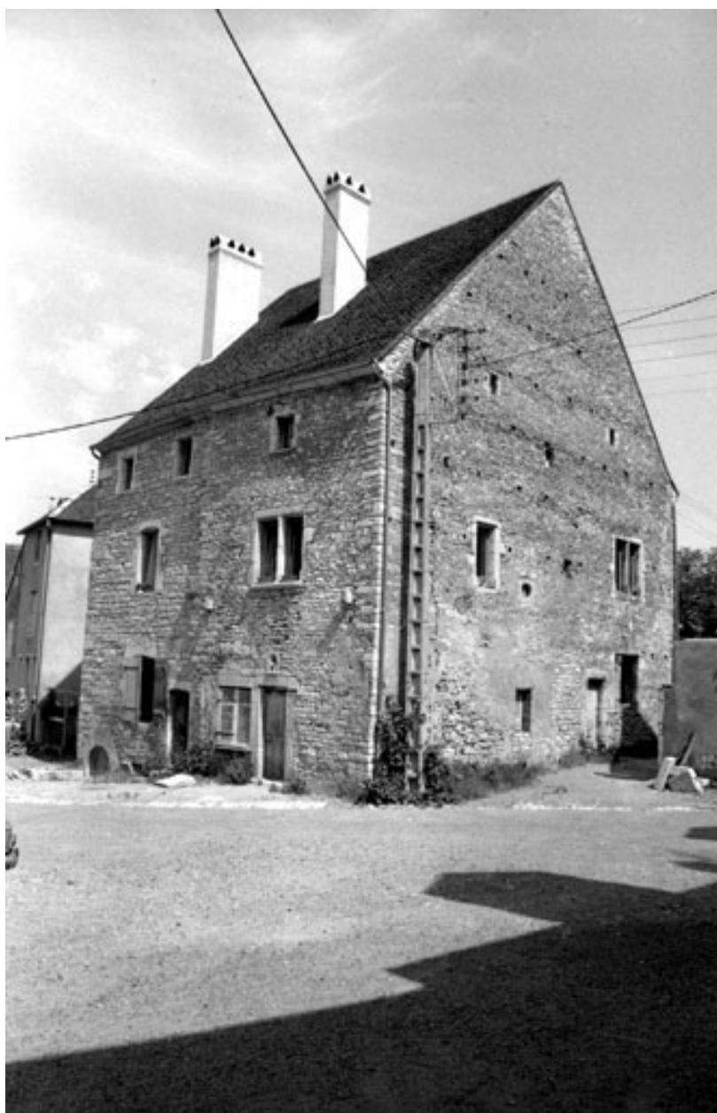
Maison située 16 rue Saint-Hilaire : vue d'ensemble.
