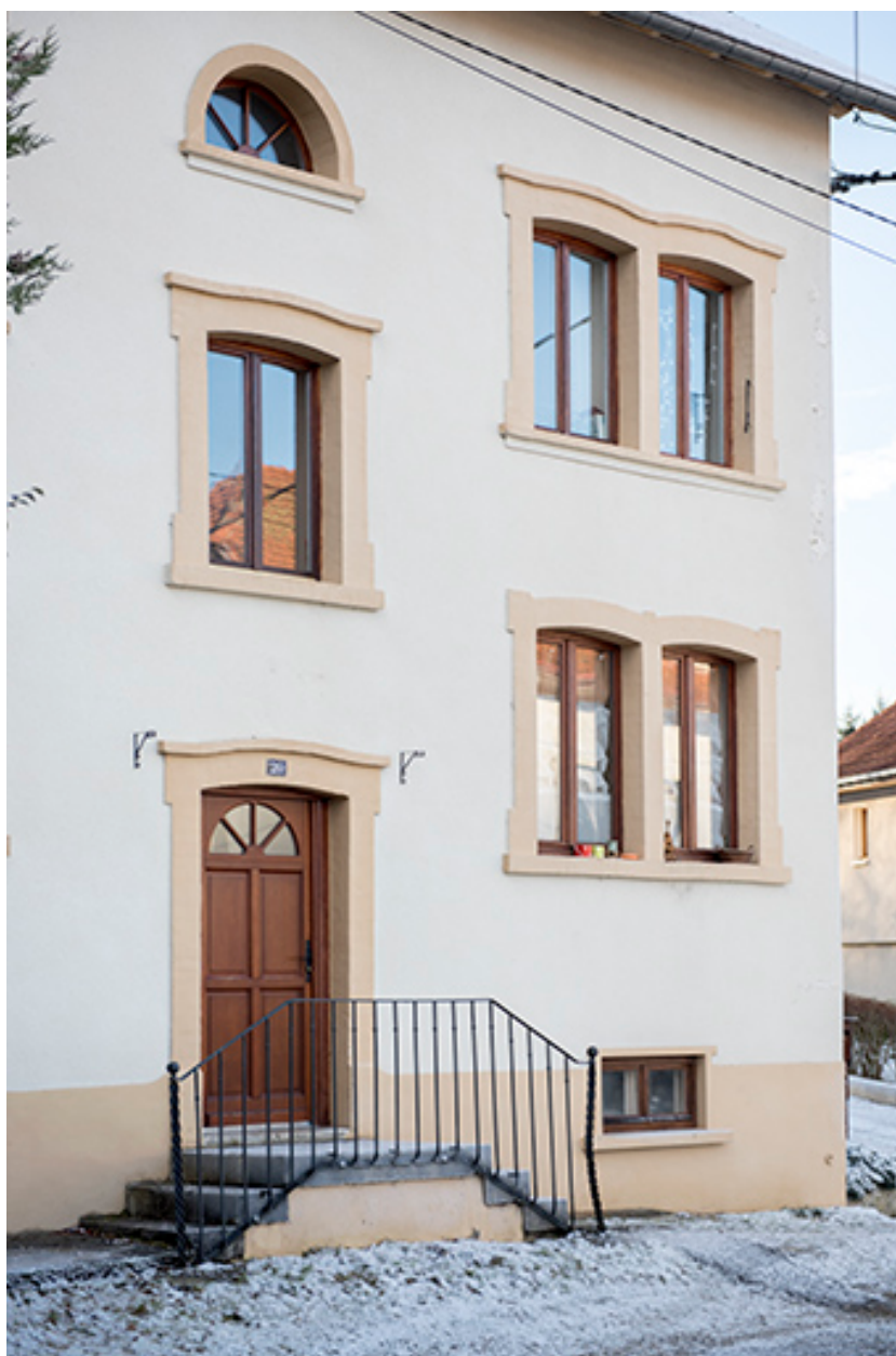
Façade antérieure : partie droite.
