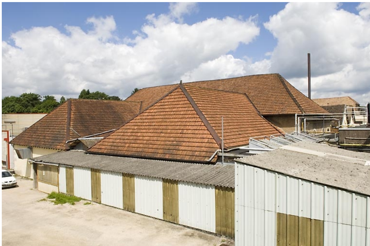
Halle de fonderie depuis le sud-est.
