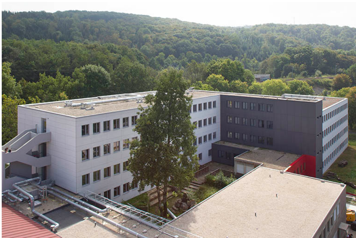
Internat : vue générale après restauration des façades.
