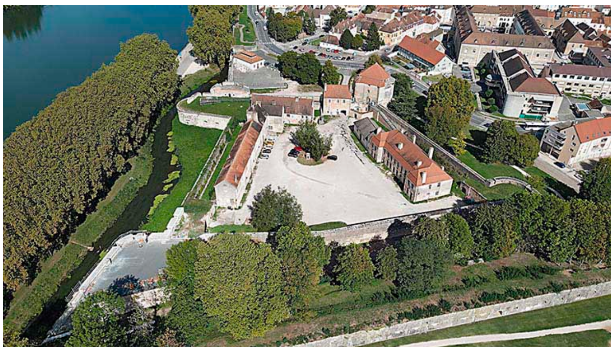
Vue aérienne du château.
