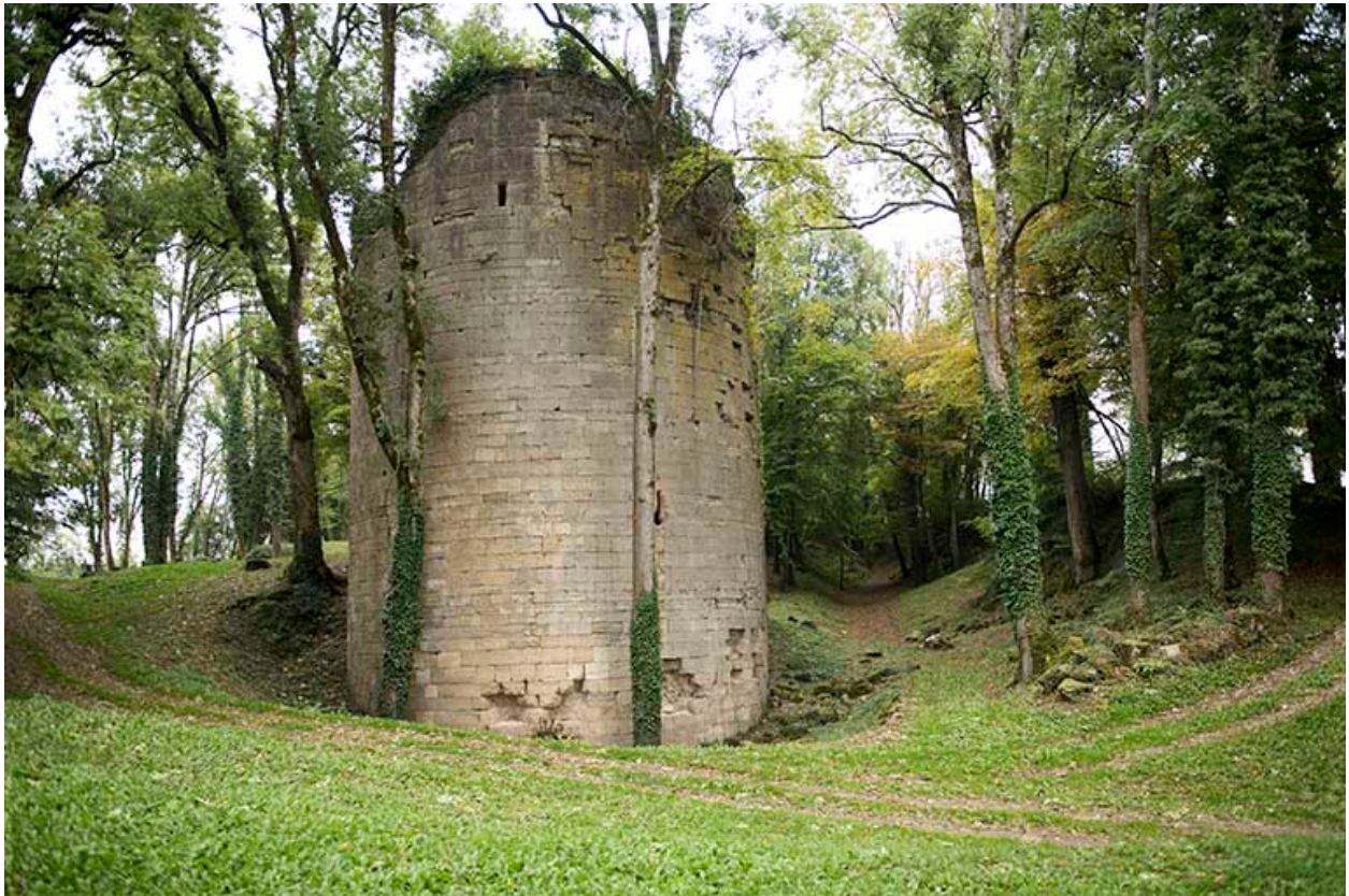
La tour ouest, vue de l'ouest.
