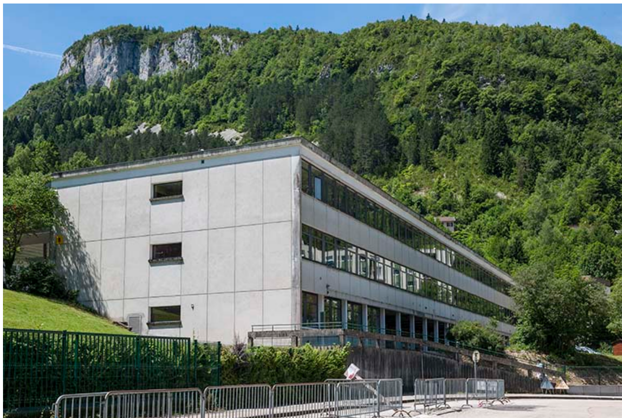
Externat : façade postérieure.
