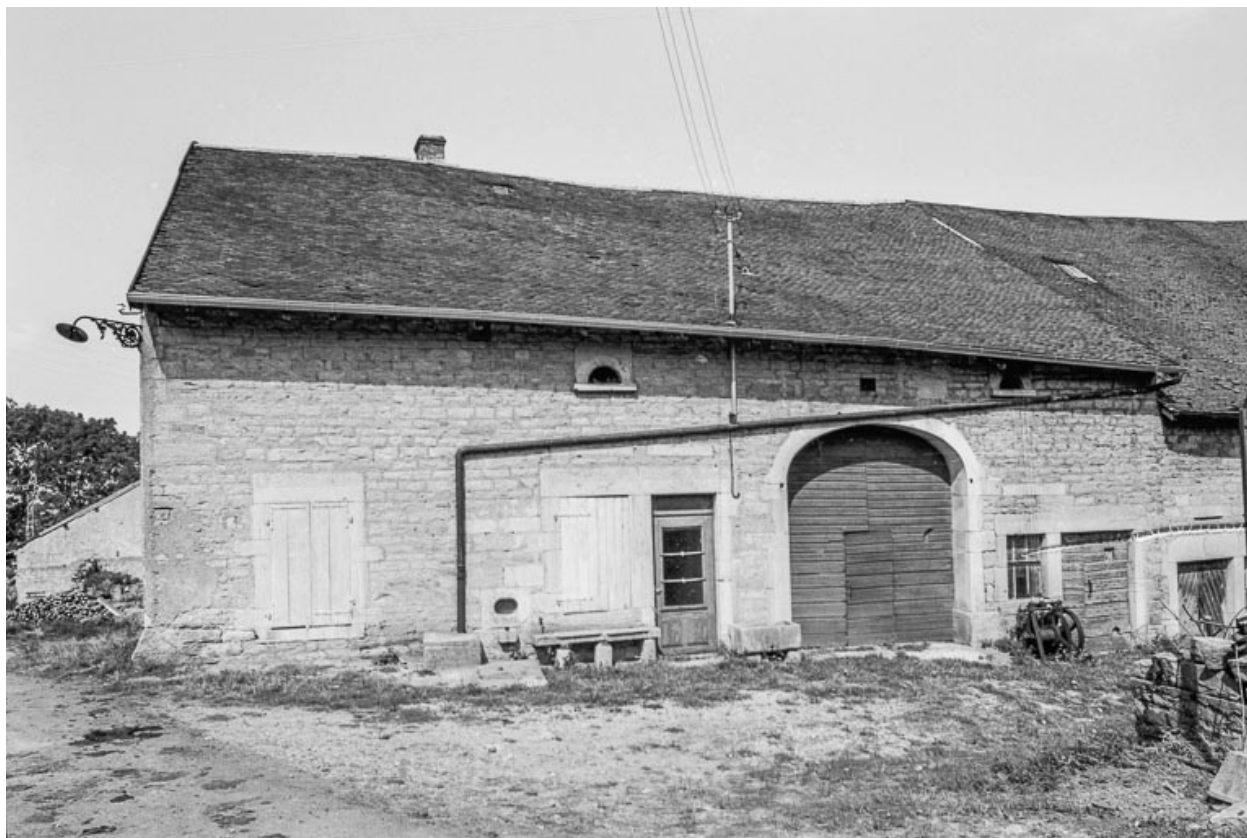
Ferme cadastrée D2 247 : façade antérieure.
