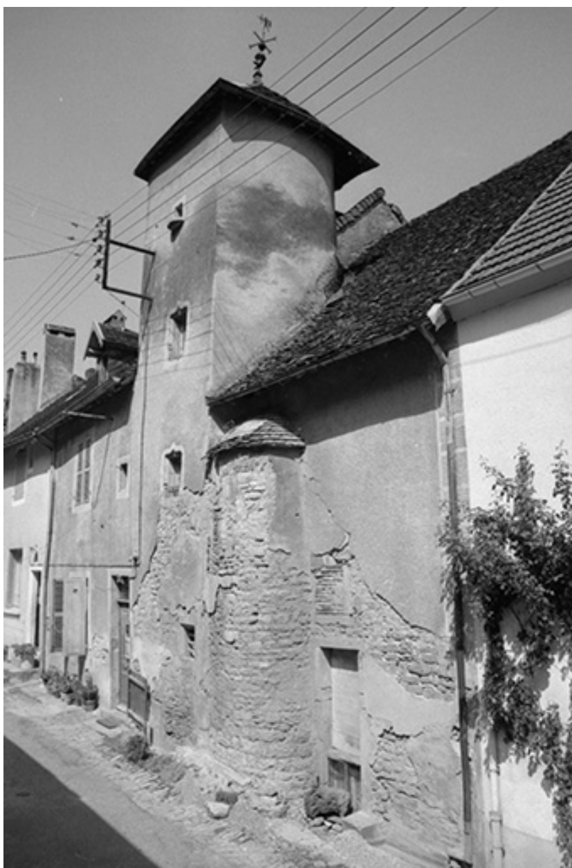
Maison avec tour d'escalier située rue Haute-du-Bourg : façade antérieure vue de trois-quarts droit.
