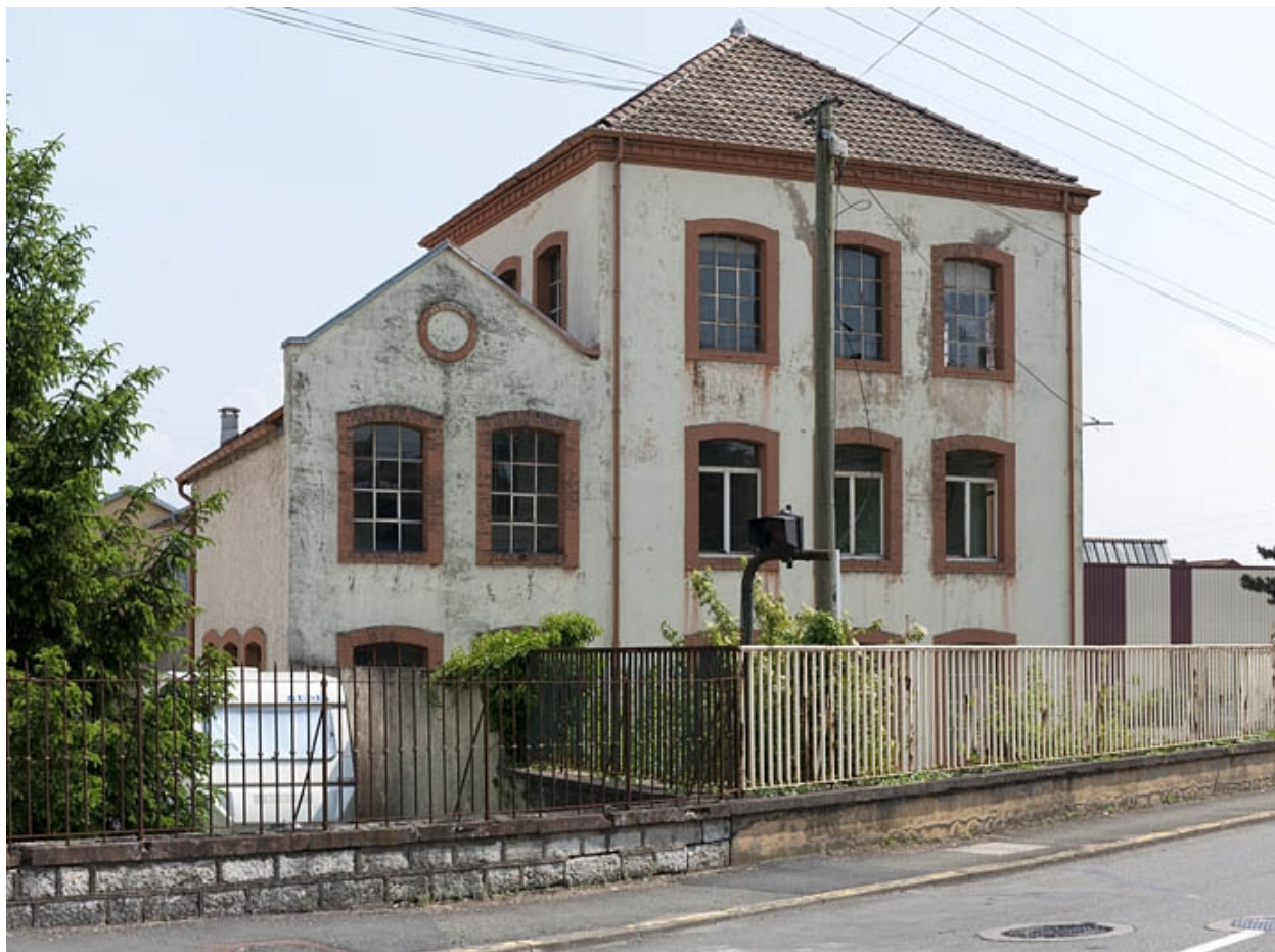
Façade sur rue du bâtiment d'entrée.
