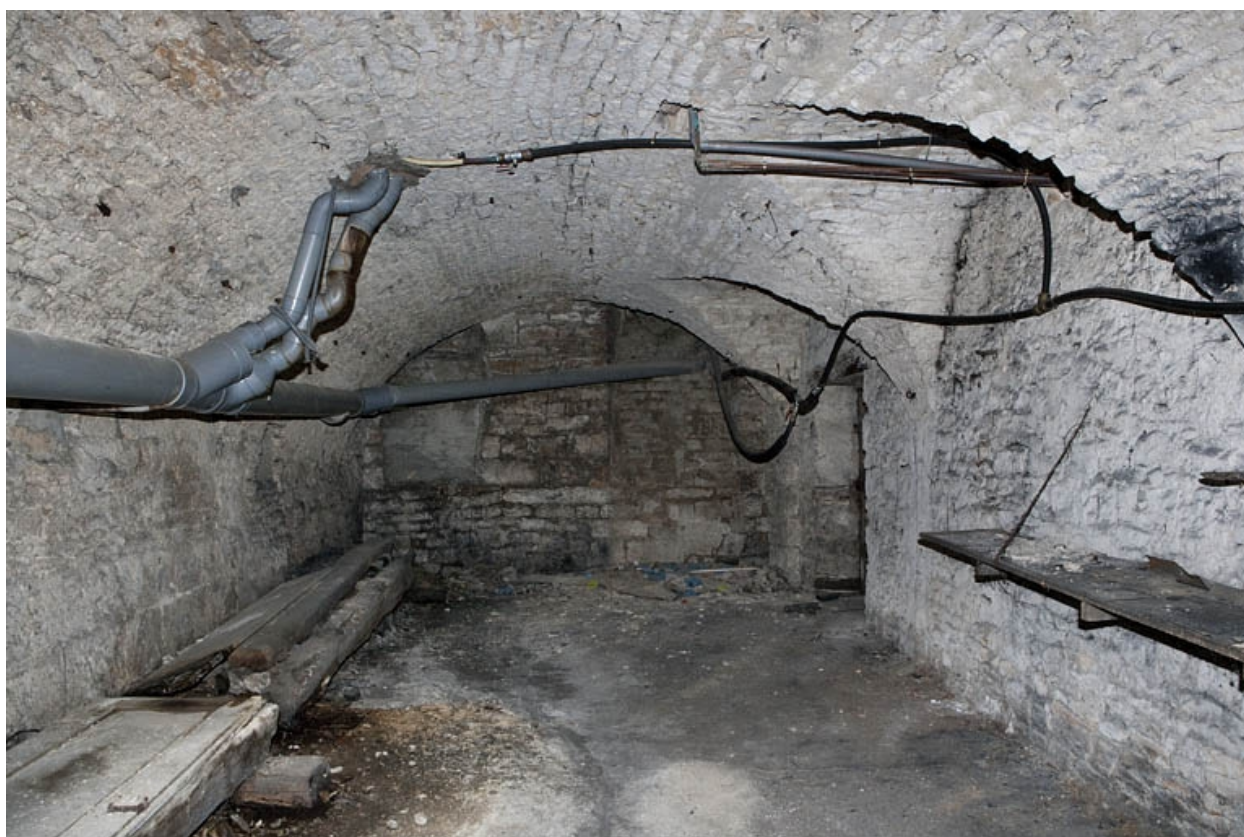
Logis principal, sous-sol : cave C, partie gauche.
