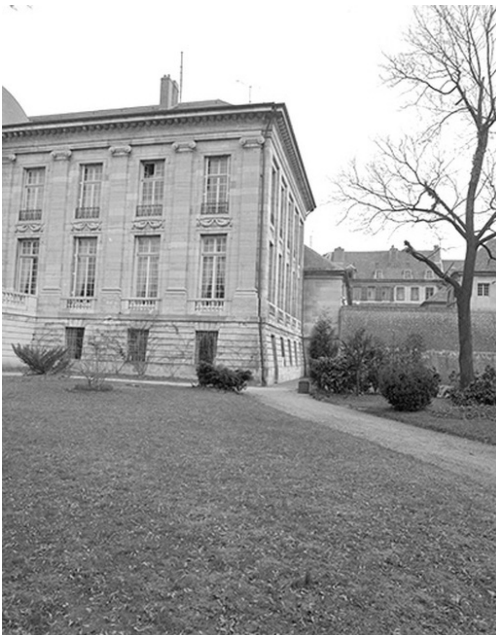
Façade postérieure : détail partie droite.
