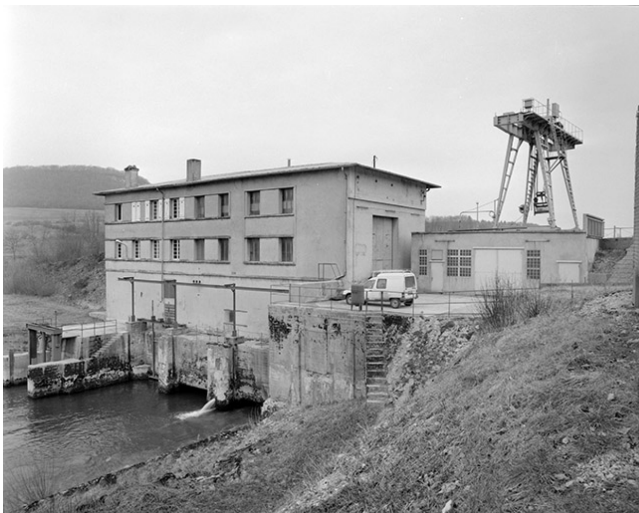
Salle des machines et atelier de réparation.
