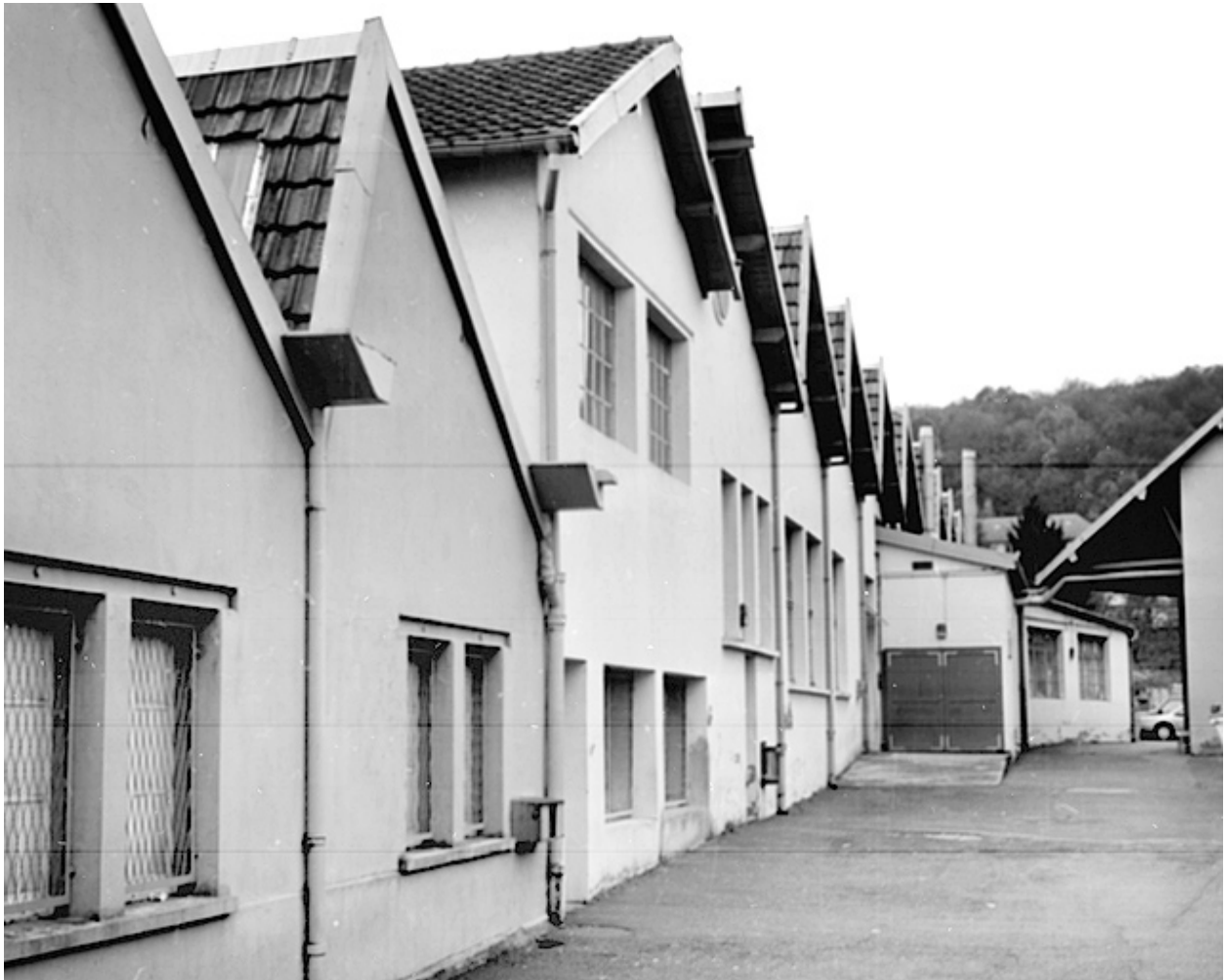
Alignement nord de l'ancien atelier de fabrication.
