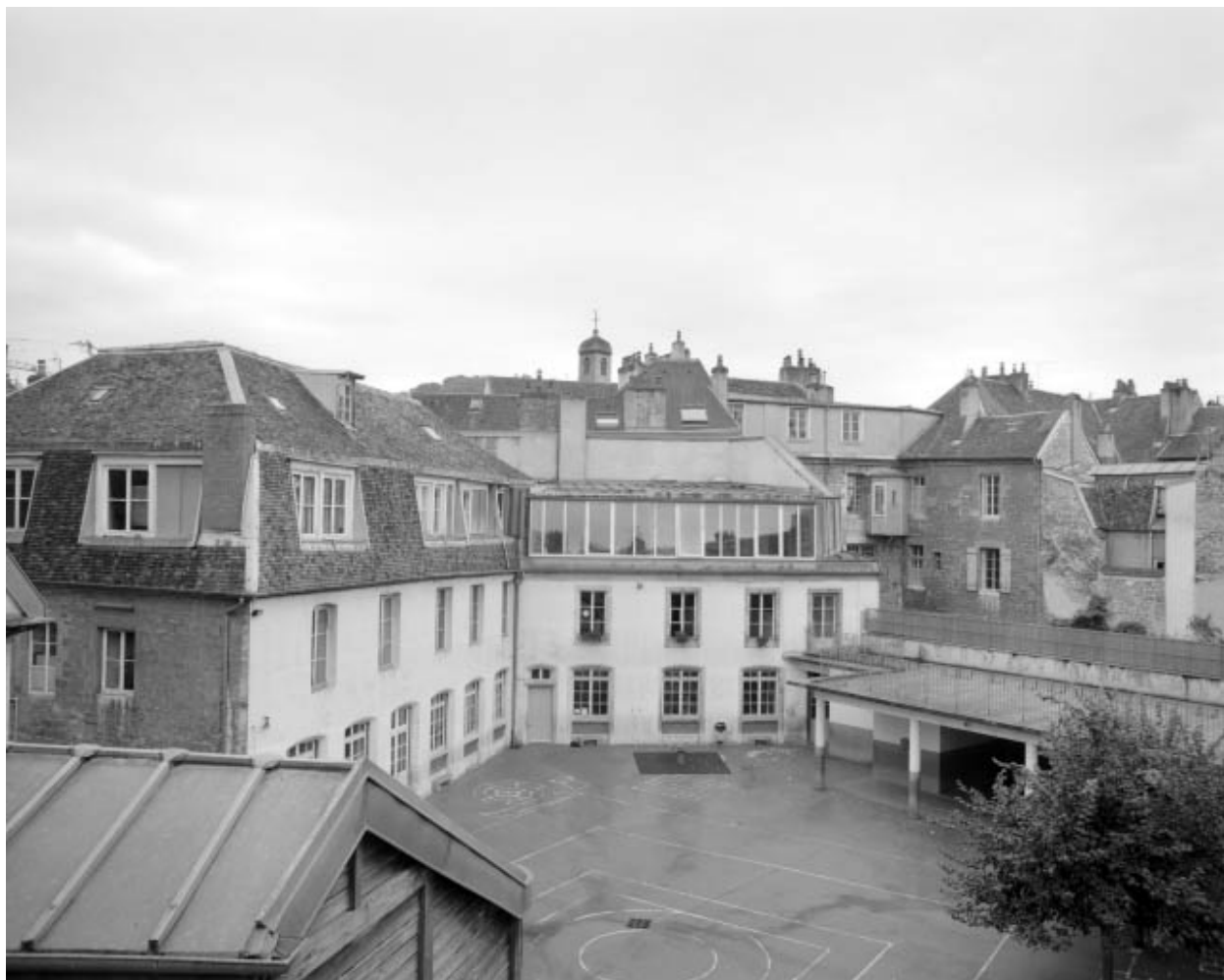
Vue d'ensemble de la deuxième cour.
