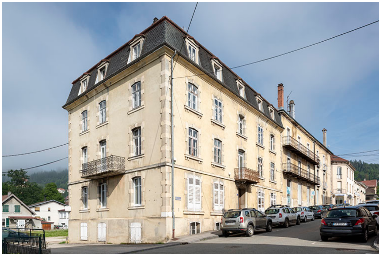
Immeuble et atelier d'horlogerie d'Emile Bonnet, 5 rue Gonsalve Pertusier.
