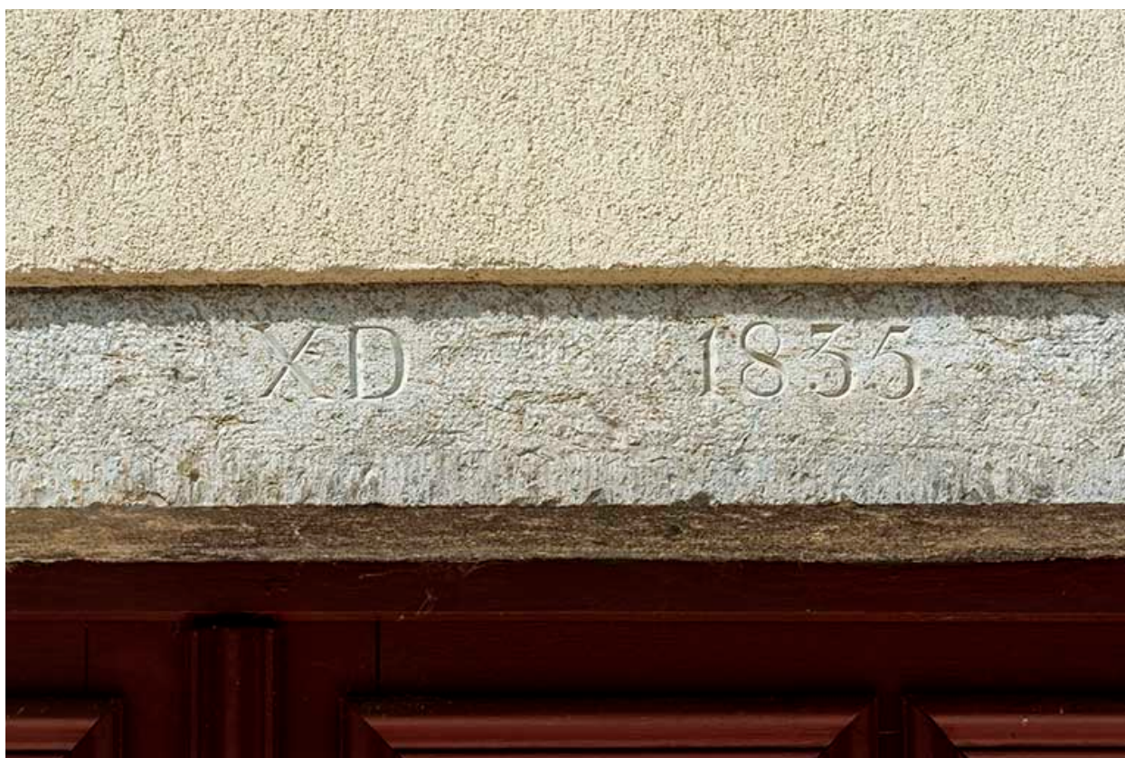
Ferme : linteau daté sur la façade antérieure.
